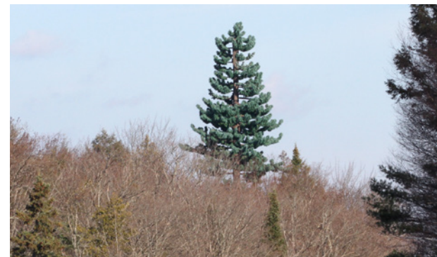
Bell certifie que chaque installation d'antenne ou de station de base, qu'il s'agisse d'une installation sur un toit ou sur une tour, respecte ou dépasse les exigences du Code de sécurité 6 du gouvernement fédéral. Dans cette image, Bell a installé une tour déguisée en arbre qui est positionnée de manière à se fondre avec l'environnement.
