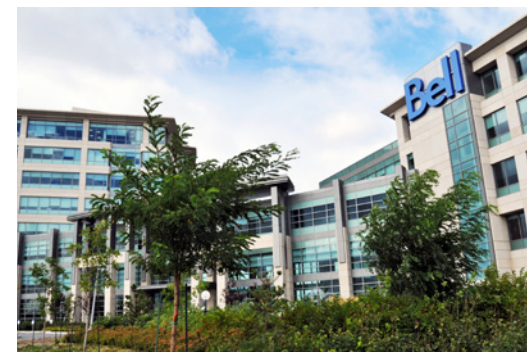
Le complexe de type Campus accueillant notre siège social, sur l'île des Sœurs, à Montréal, est le plus important immeuble commercial certifié LEED au Québec.
