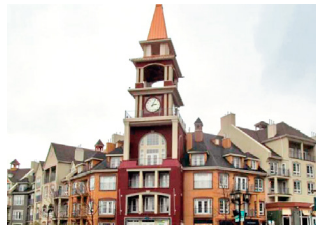
Photo d'une antenne cellulaire intégrée à une tour d'horloge.
